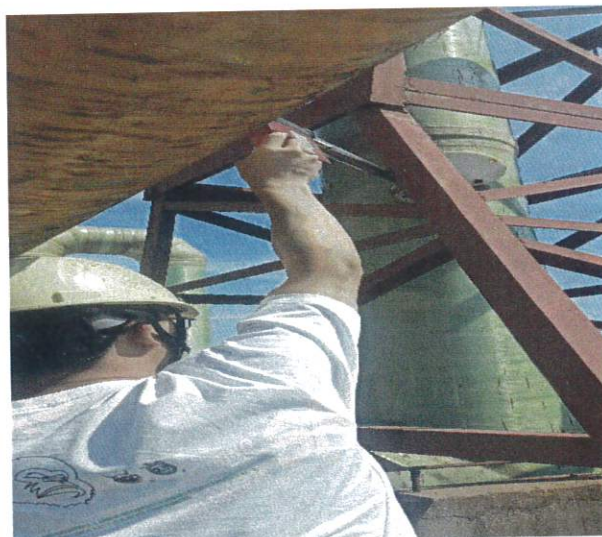
DA046 二车间综合尾气排风口
