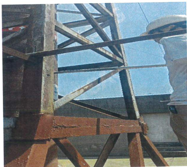
DA034 四车间综合废气排放口
