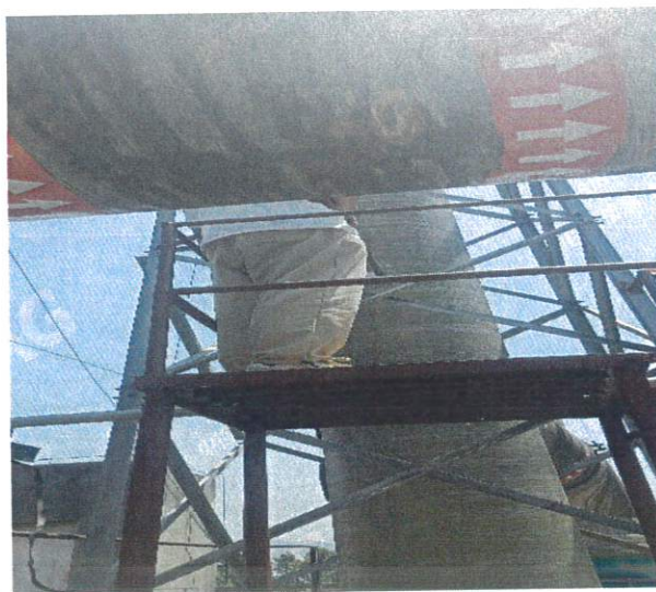
DA033 四车间氨废气排放口
