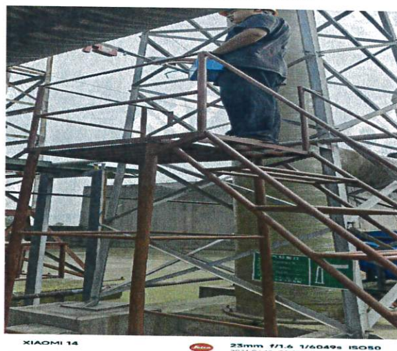
DA033 四车间氨废气排放口
