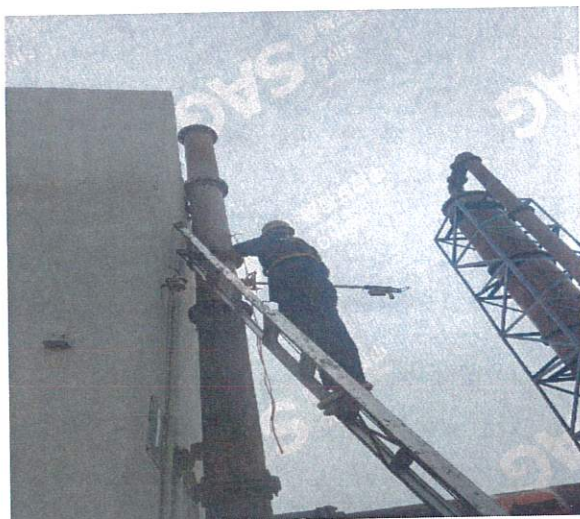
DA040 安乃近车间 FAA 回收装置废气排放口
