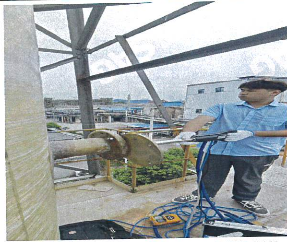
DA044 污水处理站综合废气排放口
