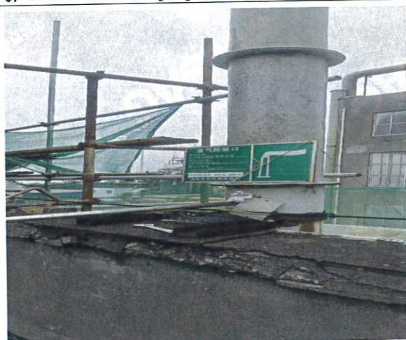
DA037 六车间废气排放口
